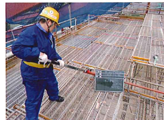
油圧ジャッキによる張力の導入
